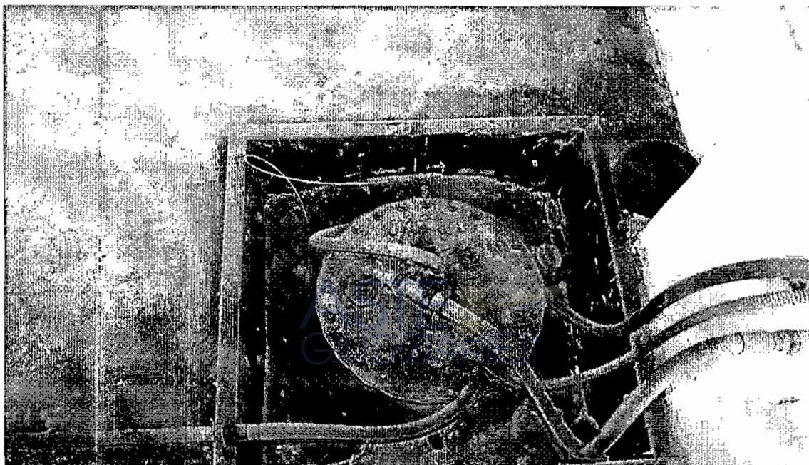
la cisterna è dotata di trattamento esterno in vetroresina, valvola limitatrice di carico, sfiato vapori, valvole di intercettazione, allarme intercapedini, allarme di troppo pieno con livello meccanico certificato atex. Alla cisterna è collegato un kit di distribuzione della benzina, certificato atex con contaltri analogico, alloggiato in apposito armadio zincato, per il riutilizzo del prodotto e dotato di filtro e allarme di cisterna vuota.
