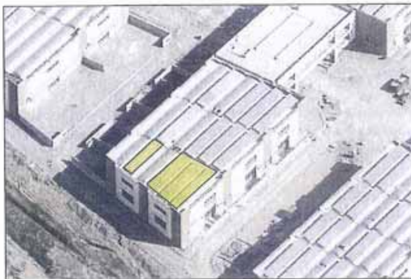
Figura 1 - Vista aerea dell'edificio con evidenziata l'area di intervento
