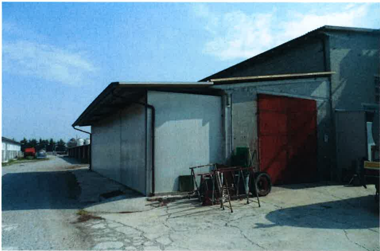
15) LOCALE DEPOSITO E OFFICINA (rif. planimetria – F)
