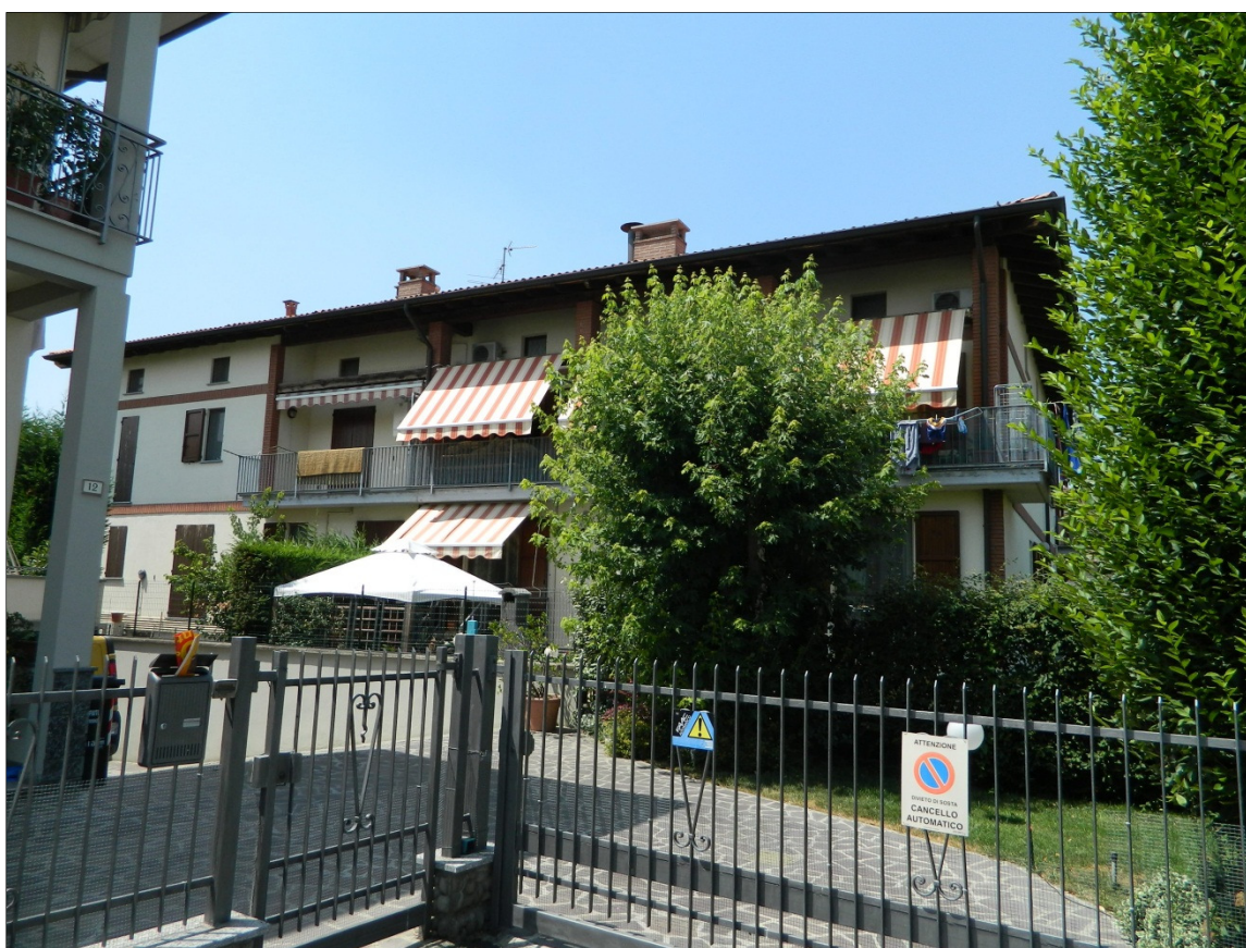
FOTO N. 2: Prospetto posteriore edificio abitativo
