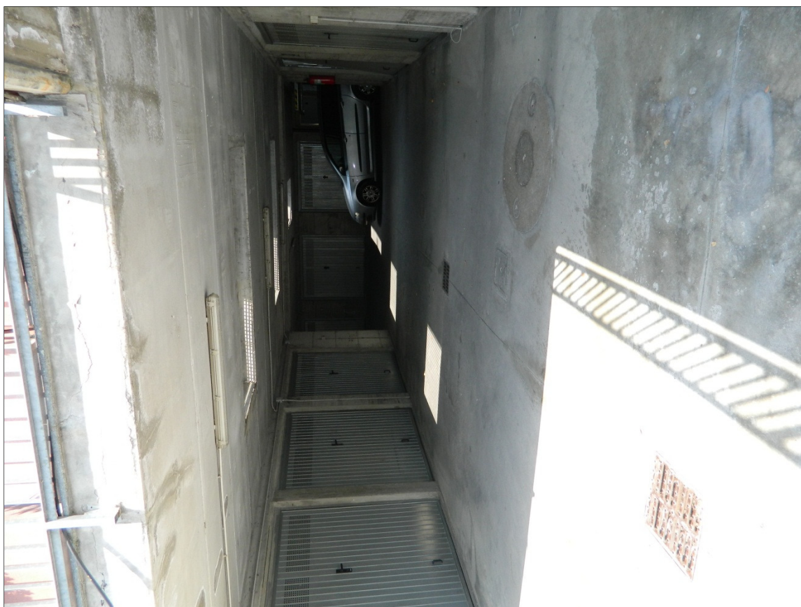
FOTO N. 18: Particolare corsello accesso autorimesse
