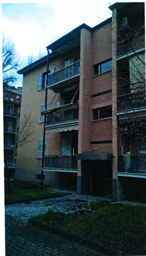
9) FOTO INGRESSO PRINCIPALE CONDOMINIO
