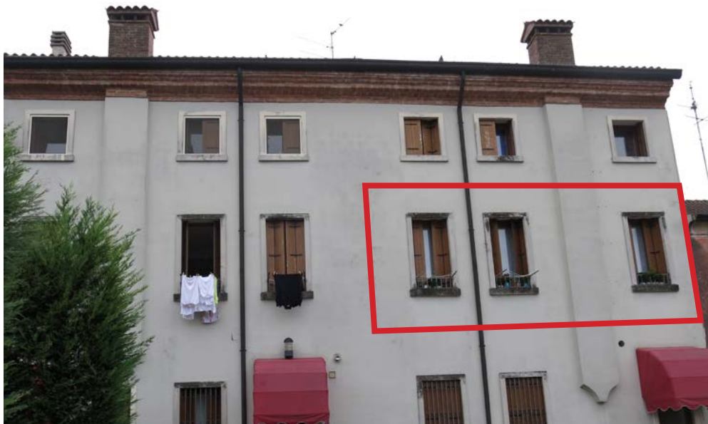
Prospetto Nord, sulla corte interna.
