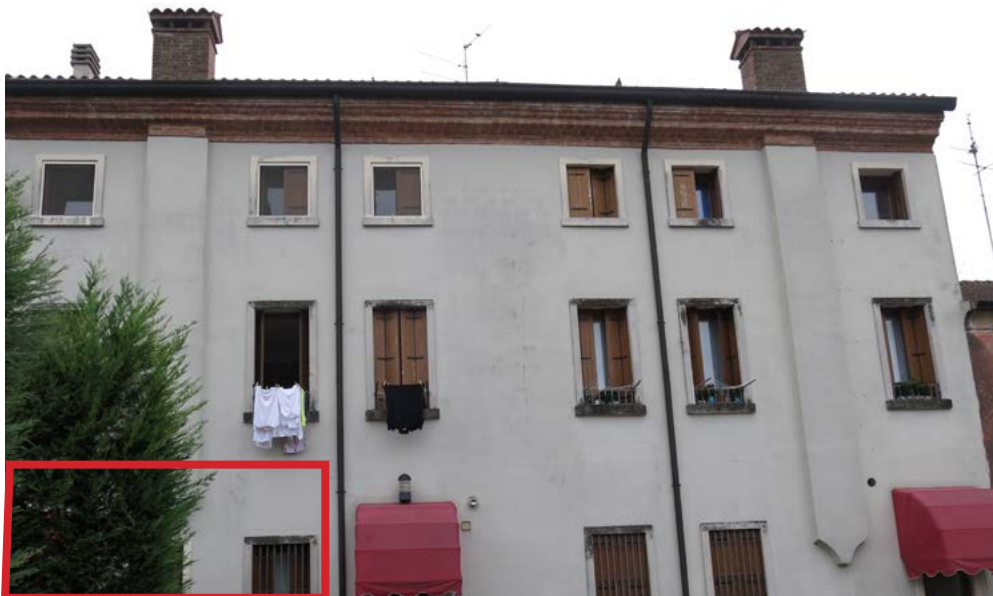
Prospetto Nord, sulla corte interna.
