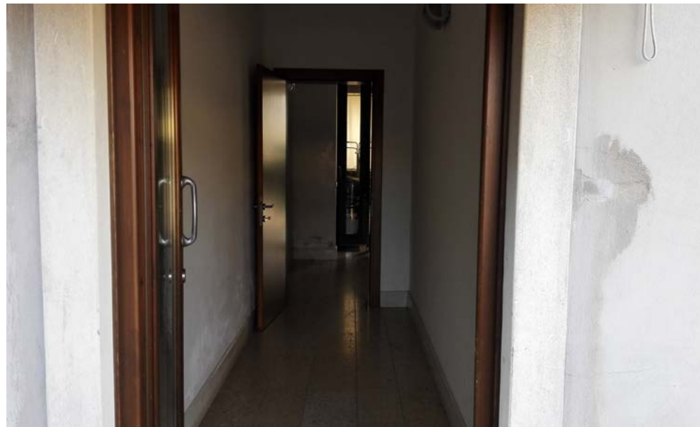
Accesso alla corte interna comune, piano terra.
