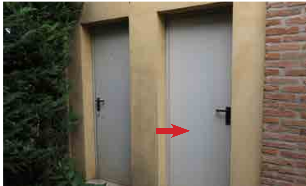
Cantina, piano terra lotto 14.
