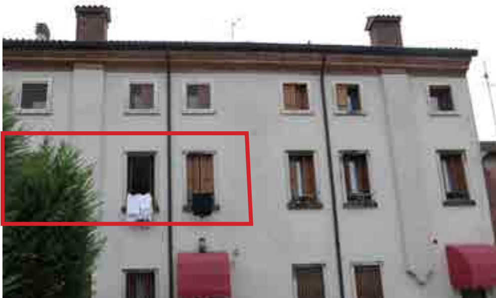
Prospetto Nord, sulla corte interna.
