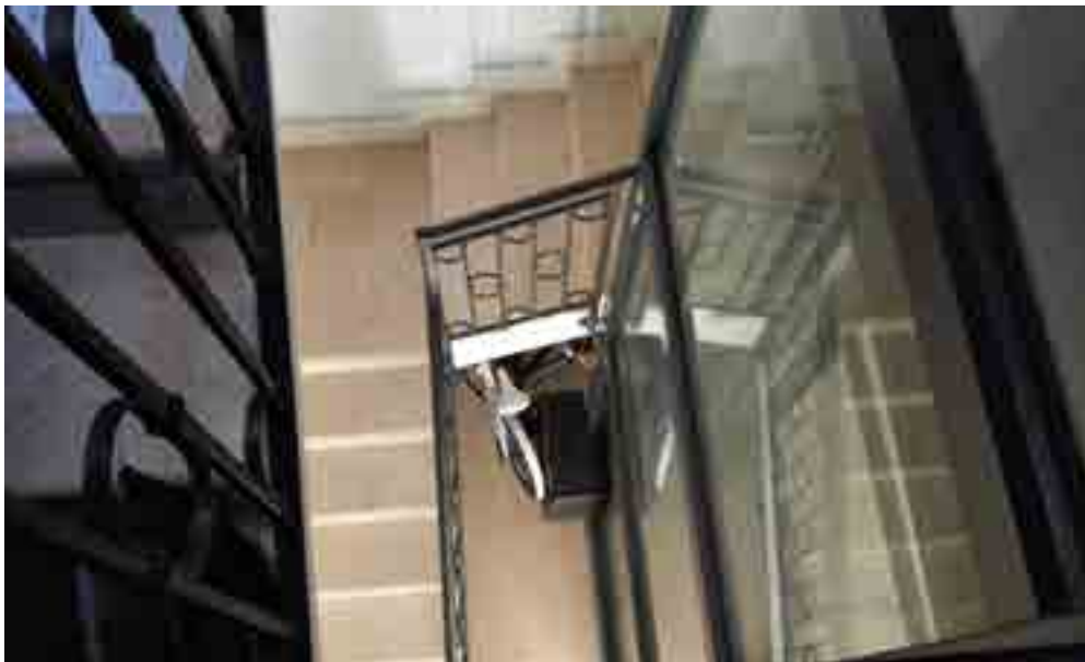
Ingresso e vano scala, piano terra.
