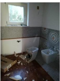
2. La villa ha subito, nel tempo, più atti vandalici e/o tentativi di furto, infatti la vista e dell'interno ne è la testimonianza. Al Piano terra risultato rotti i vetri di due delle finestre del locale soggiorno. Sono state smontate alcune delle porte interne, rovinata la Pavimentazione in parquet con schizzi di vernice e sempre con la vernice sonostate macchiate alcune pareti. E' stato rotto il deumidificatore posto alla base della scalinata interna, e demolito un bidet.
