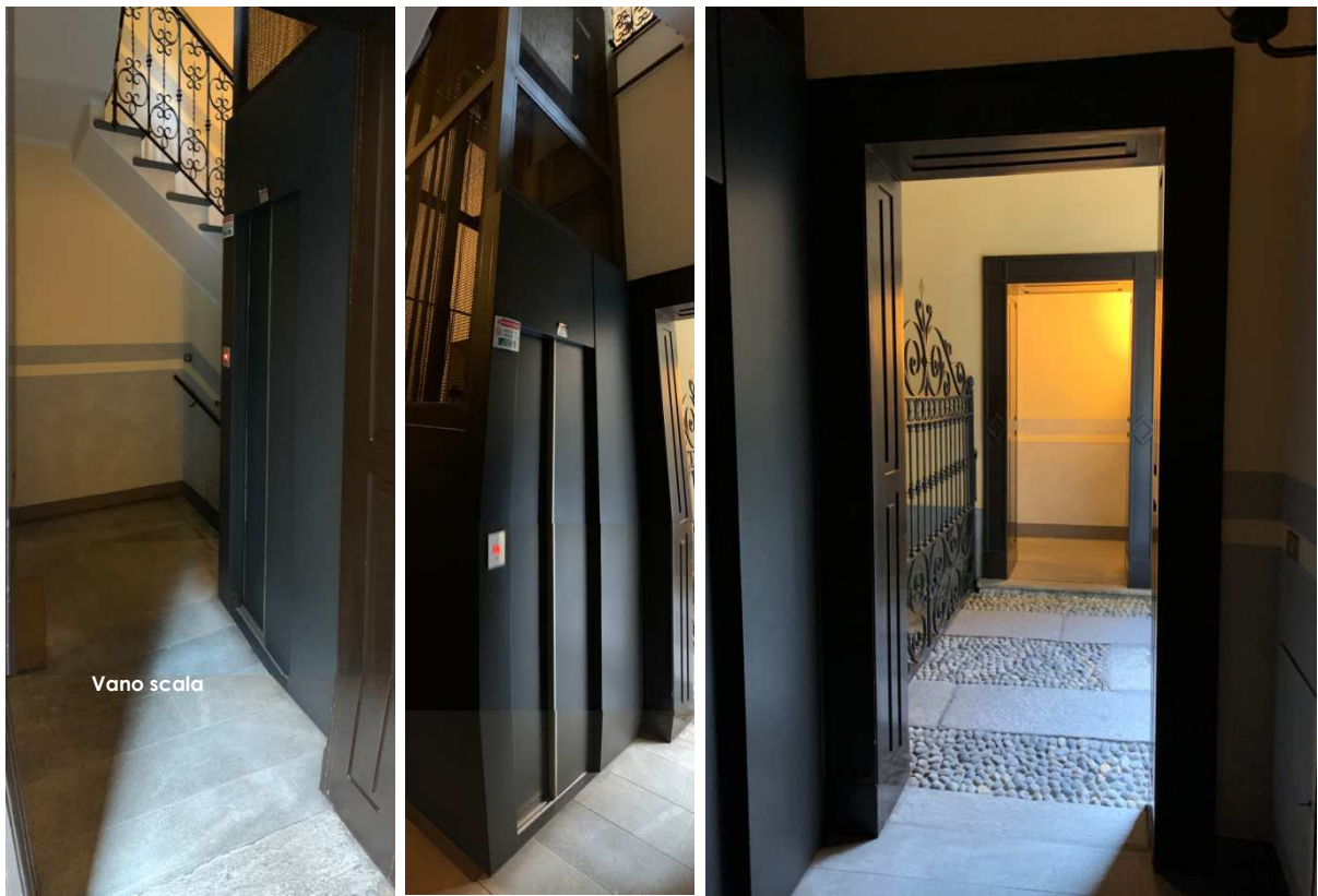
Foto nn. 8-9-10. Vano scala e ascensore condominiale
