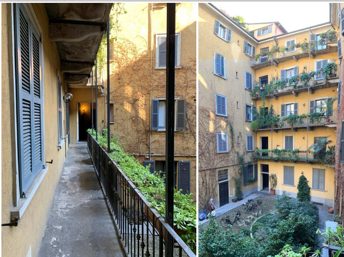
Foto nn. 12-13. Piano Primo. Ballatoio comune e affaccio sulla corte
