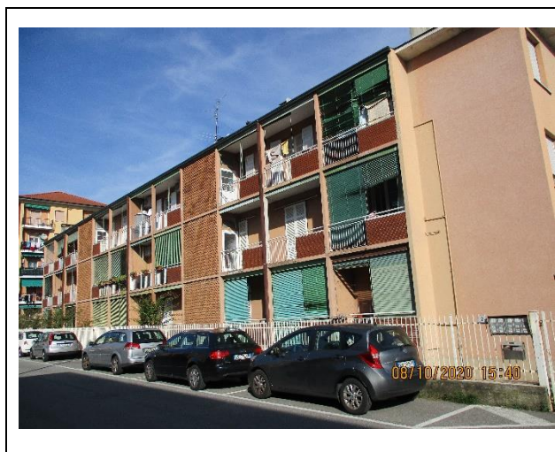
Fabbricato – facciata verso strada
