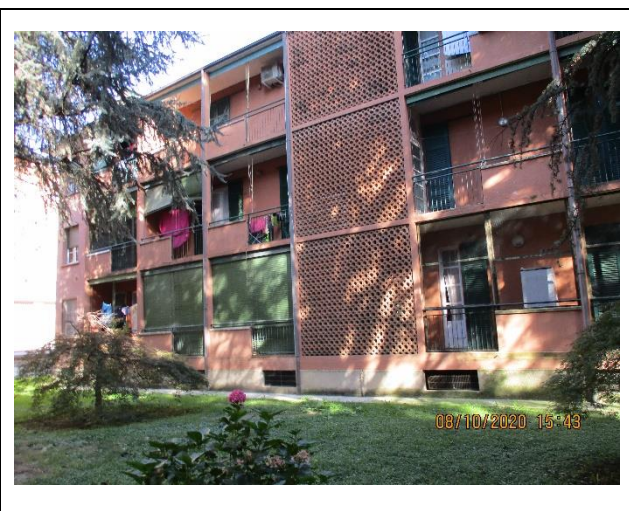
Fabbricato: facciata verso cortile
