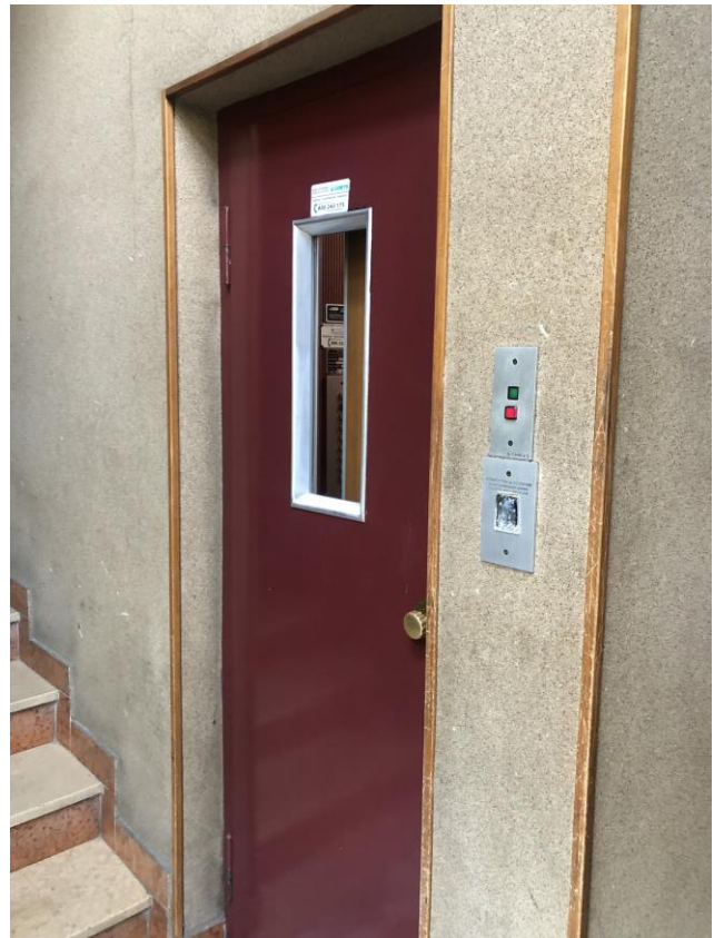
Vista vano ascensore
