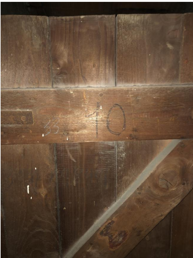
Vista porta solaio di pertinenza
