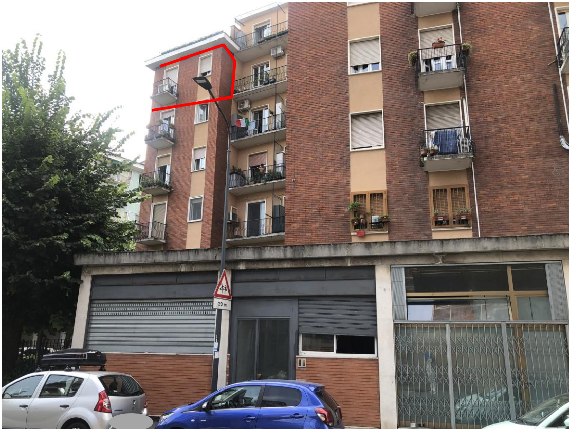
Vista dello stabile da Via Vignati
