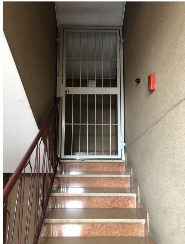
Vista cancello ai solai
