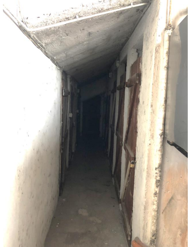
Vista spazi comuni solai
