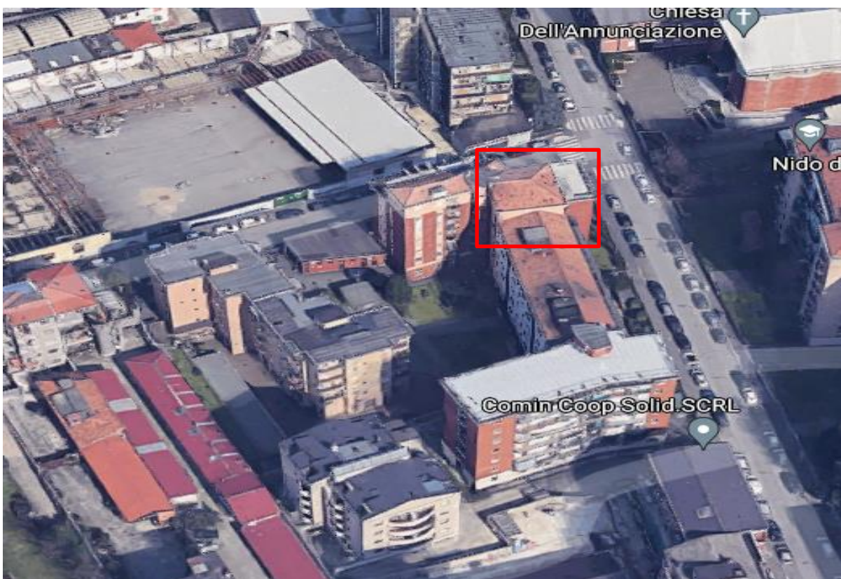
Vista assonometrica del fabbricato da Google Maps
