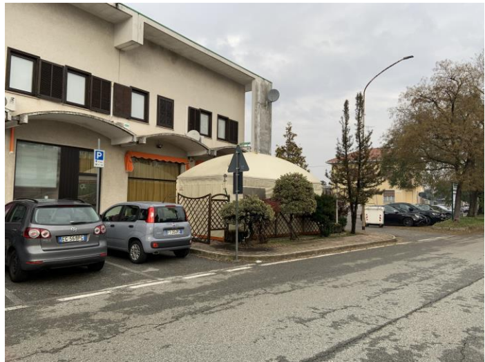
2_ prospetto lato est (Via Gorizia)
