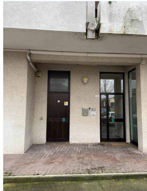
4_ingresso retro (Via Foscolo)
