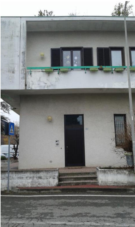
1_prospetto e ingresso lato est (Via Gorizia)
