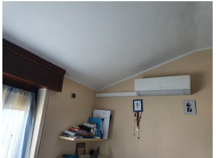
Particolare sagoma dei plafoni
