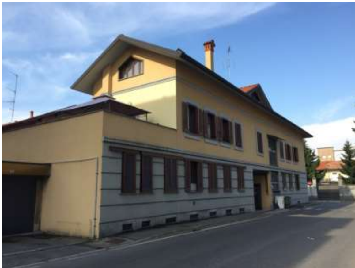
Foto 01 - Il fabbricato su via Casati
