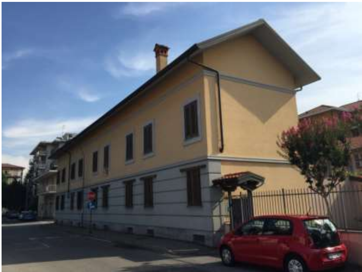
Foto 03 - Il fabbricato su via Colombo
