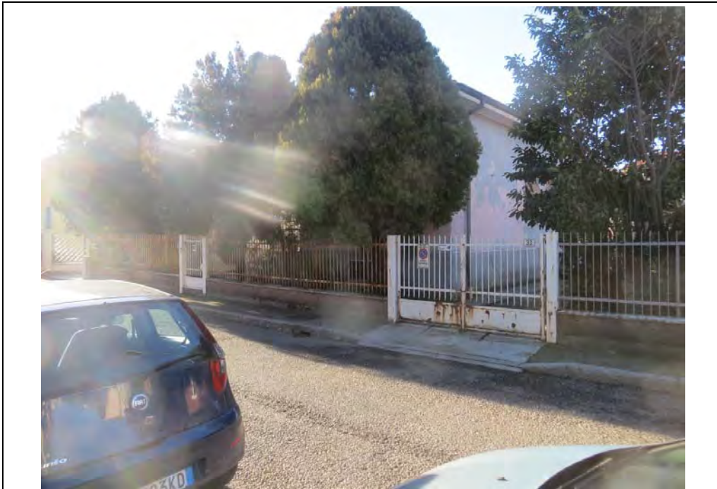
Vista del fabbricato da via Milano
