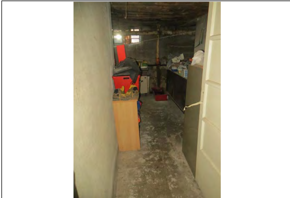
Vista dei locali al piano seminterrato
