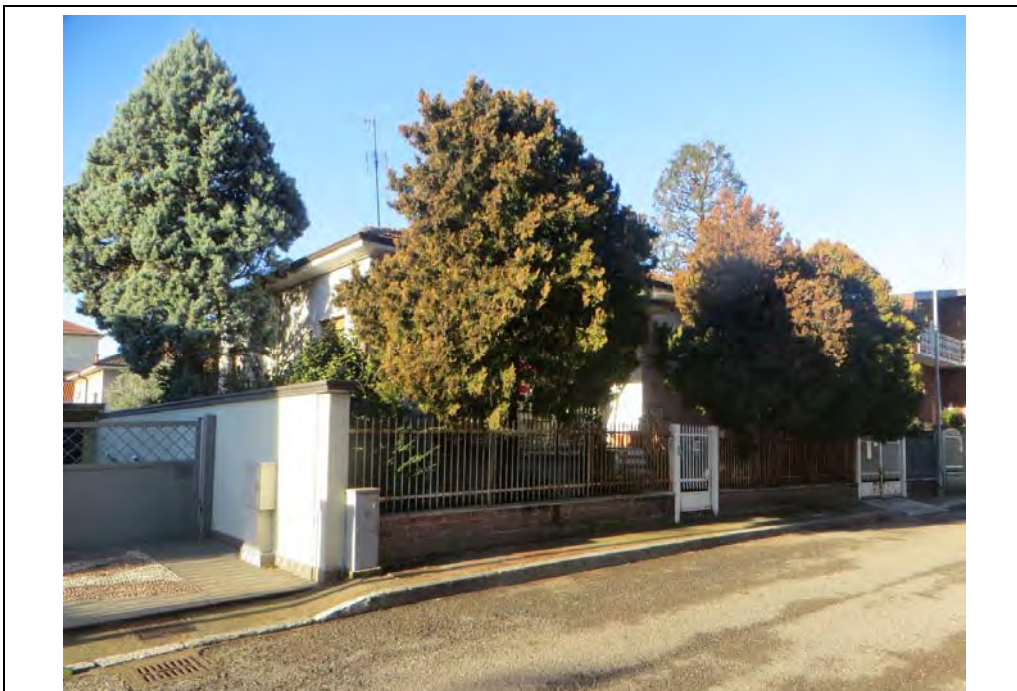
Vista del fabbricato da via Milano
