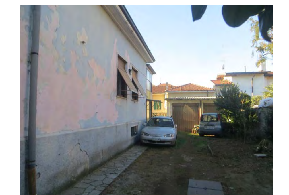
Vista del fabbricato dal giardino interno
