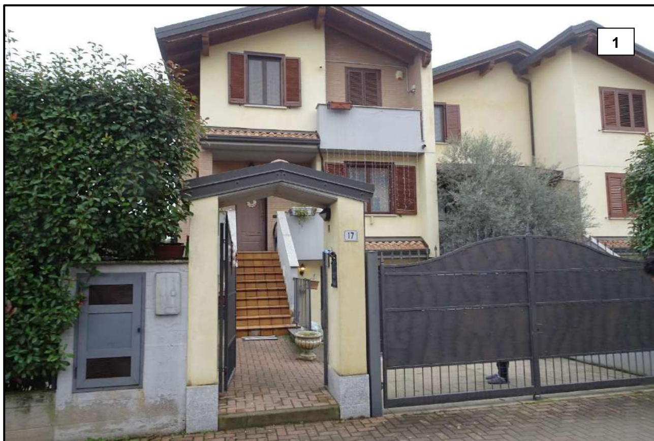
VISTA FRONTALE ESTERNA DA VIA SARACCHI
