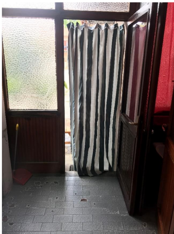
Foto n. 4: Ingresso lato cortile.
