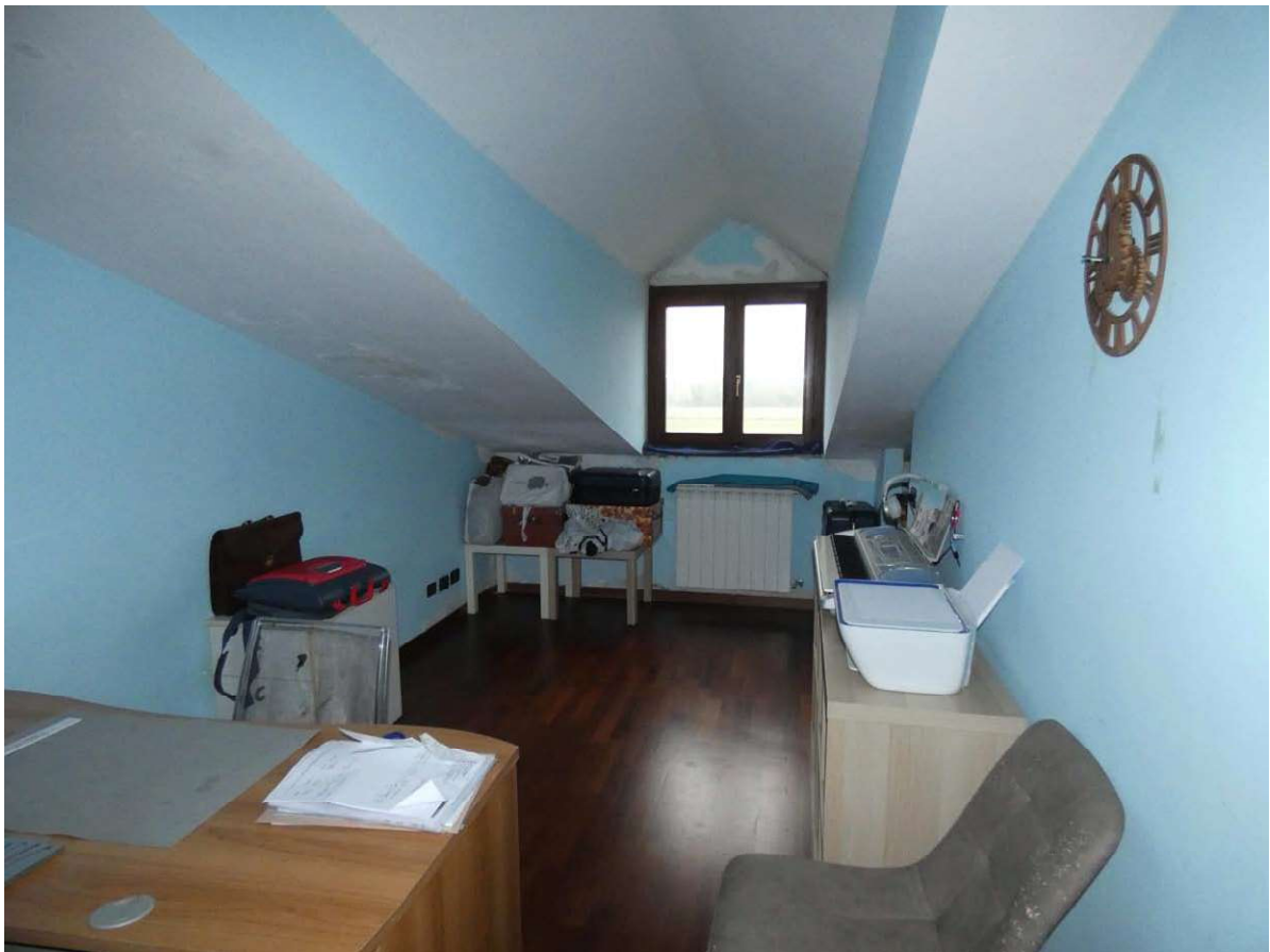
Foto 21. Sottotetto non abitabile
