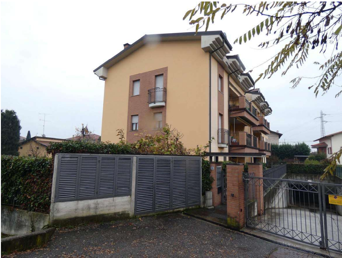
Foto 1. Prospetto su Via Pietro Nenni
