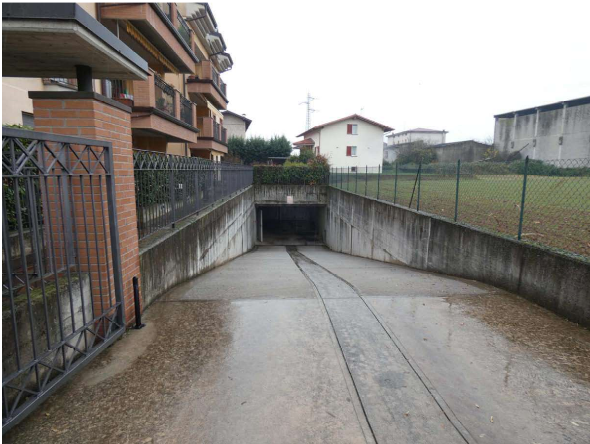
Foto 12. Rampa d'accesso ai box auto
