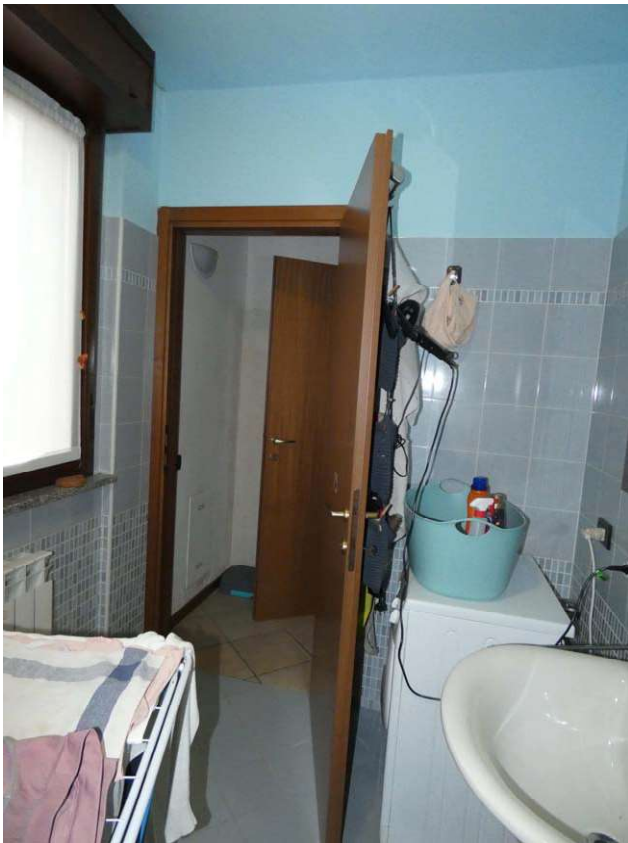
Foto 15. Bagno e disimpegno
