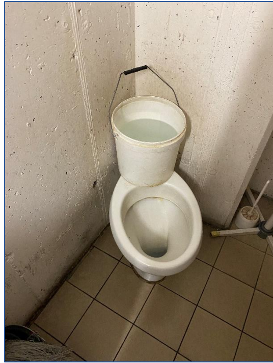
Foto 9 - interni (dettaglio vano wc)
