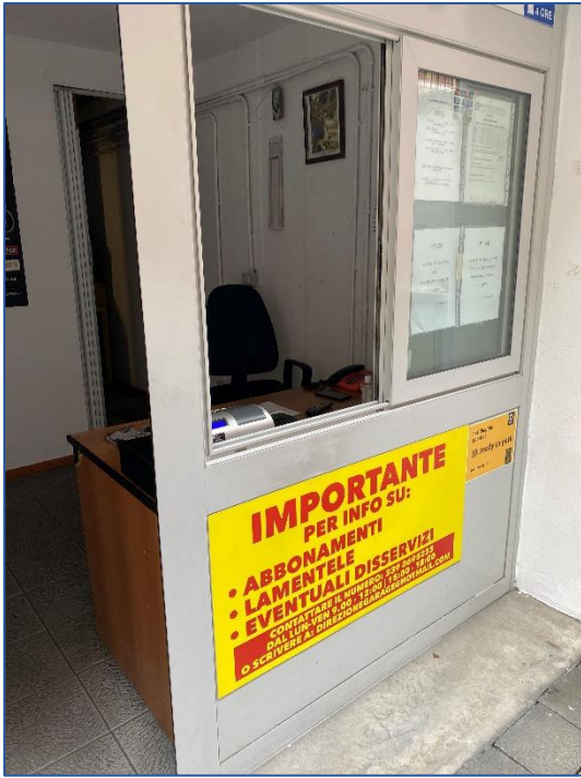
Foto 4 - dettaglio serramenti esterni
