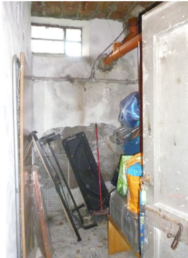
FOTO 16 – Interno vano cantina
