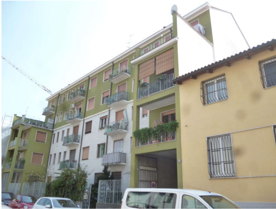
FOTO 1 – Milano, edificio Via Giovanni da Verrazzano 26/A-B
