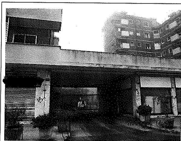
Accesso al complesso del civico 130
