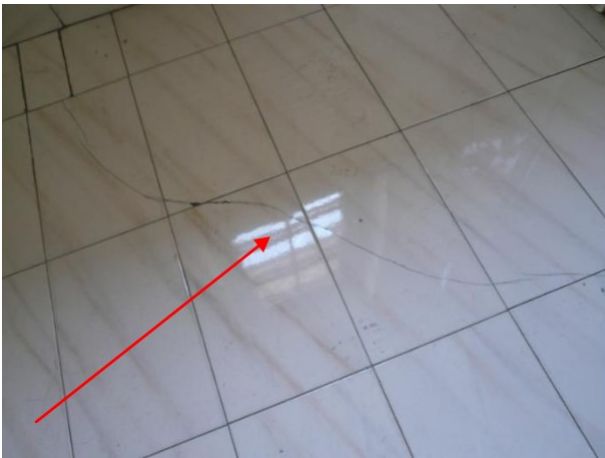
Bagno Piano Primo
