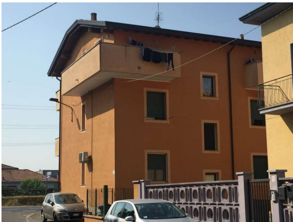
Foto n.1 – prospetto su via Ariosto
