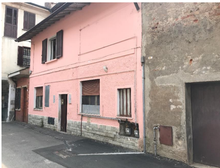
Foto n. 1: Prospetto principale su strada.
