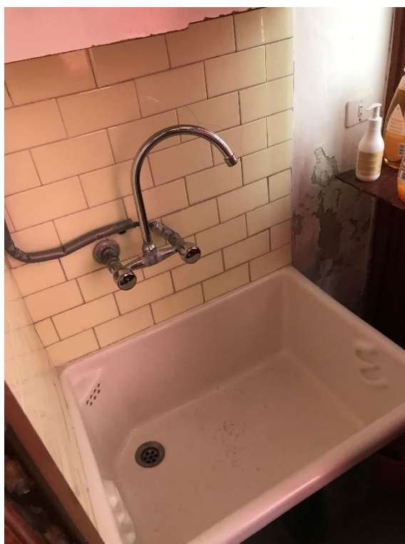
Foto n. 5: Particolare lavatoio (servizio igienico).
