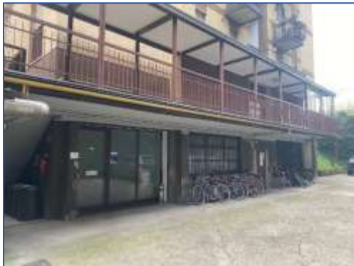
Foto 18 - ingresso da cortile comune
