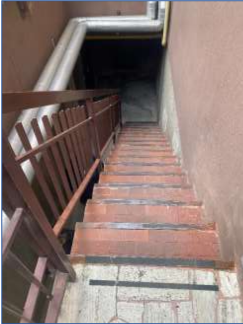
Foto 9 - scala comune esterna
