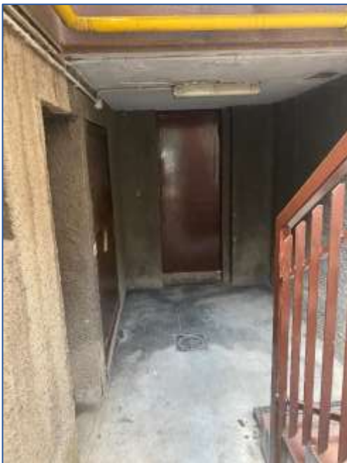
Foto 11 - ingresso da cortile comune
