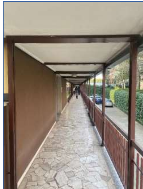
Foto 8 - passerella esterna di collegamento
