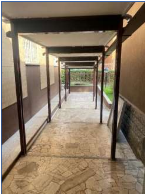
Foto 7 - passerella esterna di collegamento
