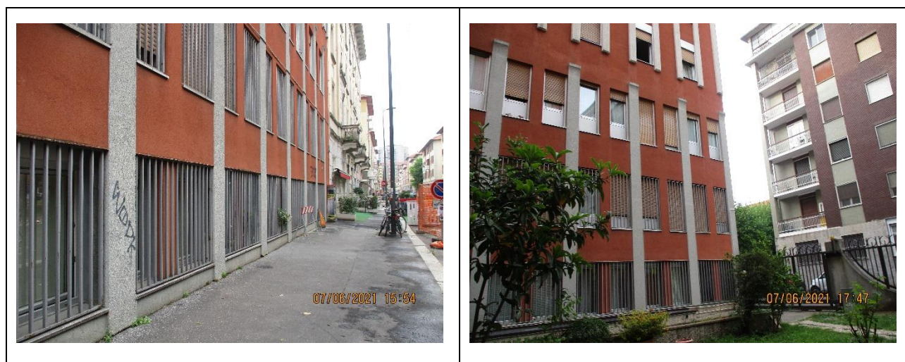
Vista dei serramenti delle unità verso Via Barrili
