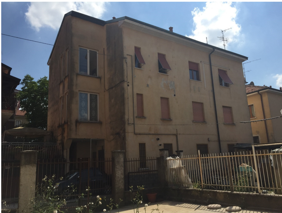
Foto 01 - Il fabbricato su via Marconi 25
