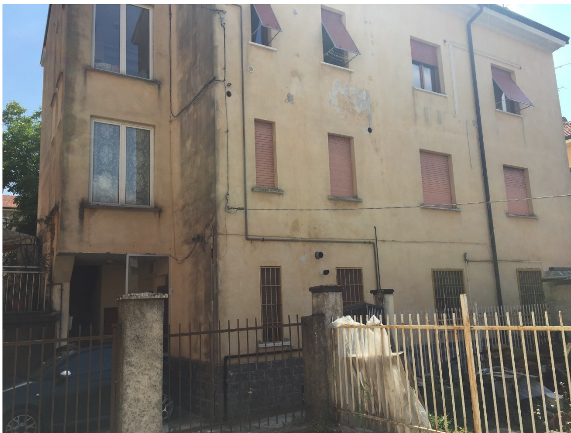
Foto 02 - Il fabbricato su via Marconi 25
