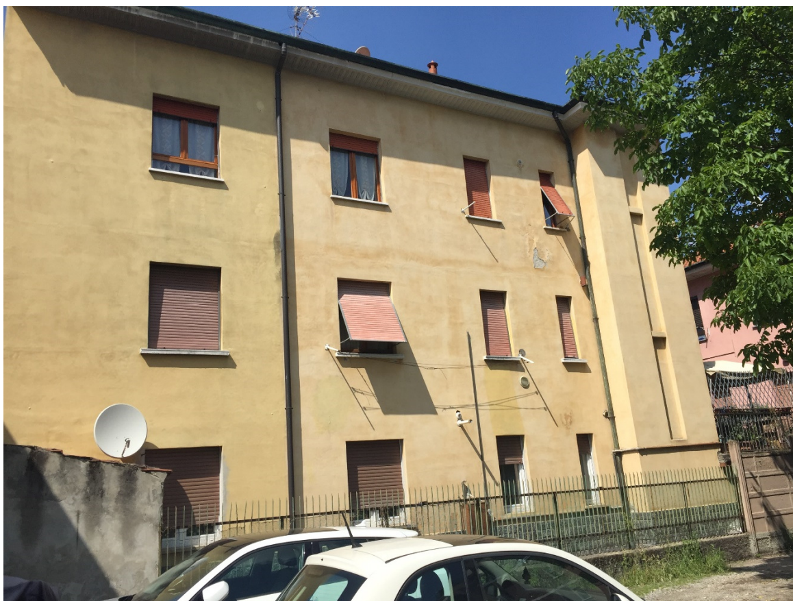
Foto 04 - Retro del fabbricato
