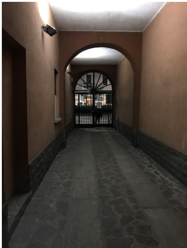
Foto n. 3: cancello ed androne comune di ingresso.
