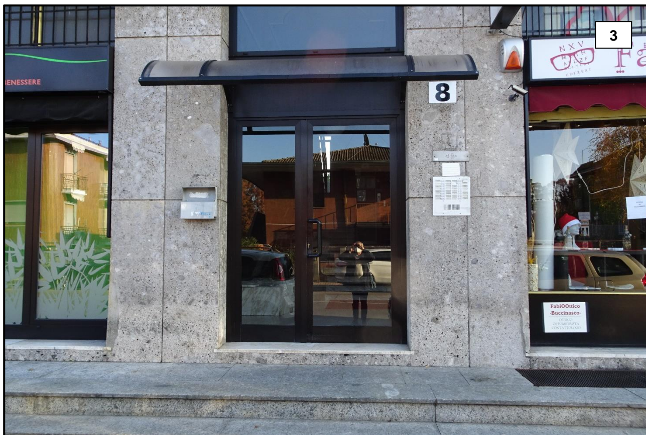
ACCESSO PEDONALE AL VANO SCALA (vista esterna da area cortilizia)
