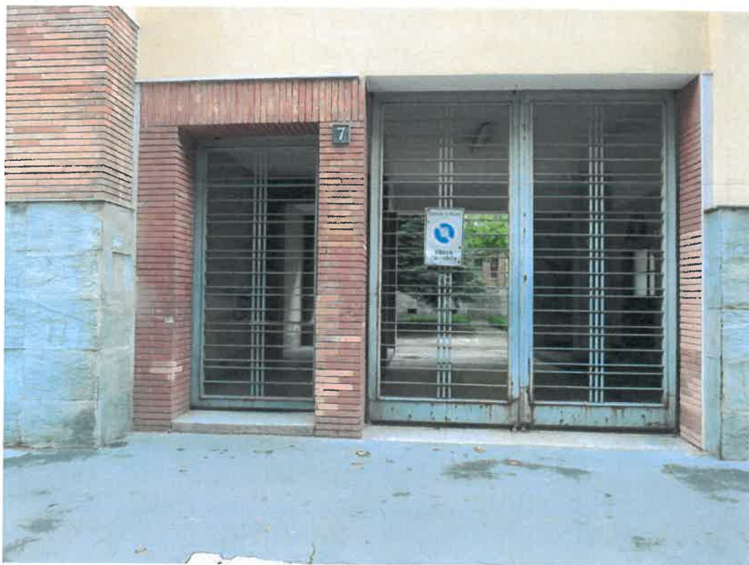
INGRESSO COMPLESSO IMMOBILIARE
