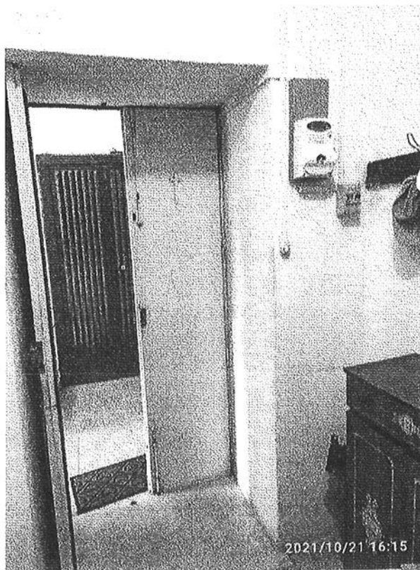
FOTO 4 (sopra) – vista del portoncino d'ingresso e tratti dell'impianto elettrico con canalette esterne sopra muro.
